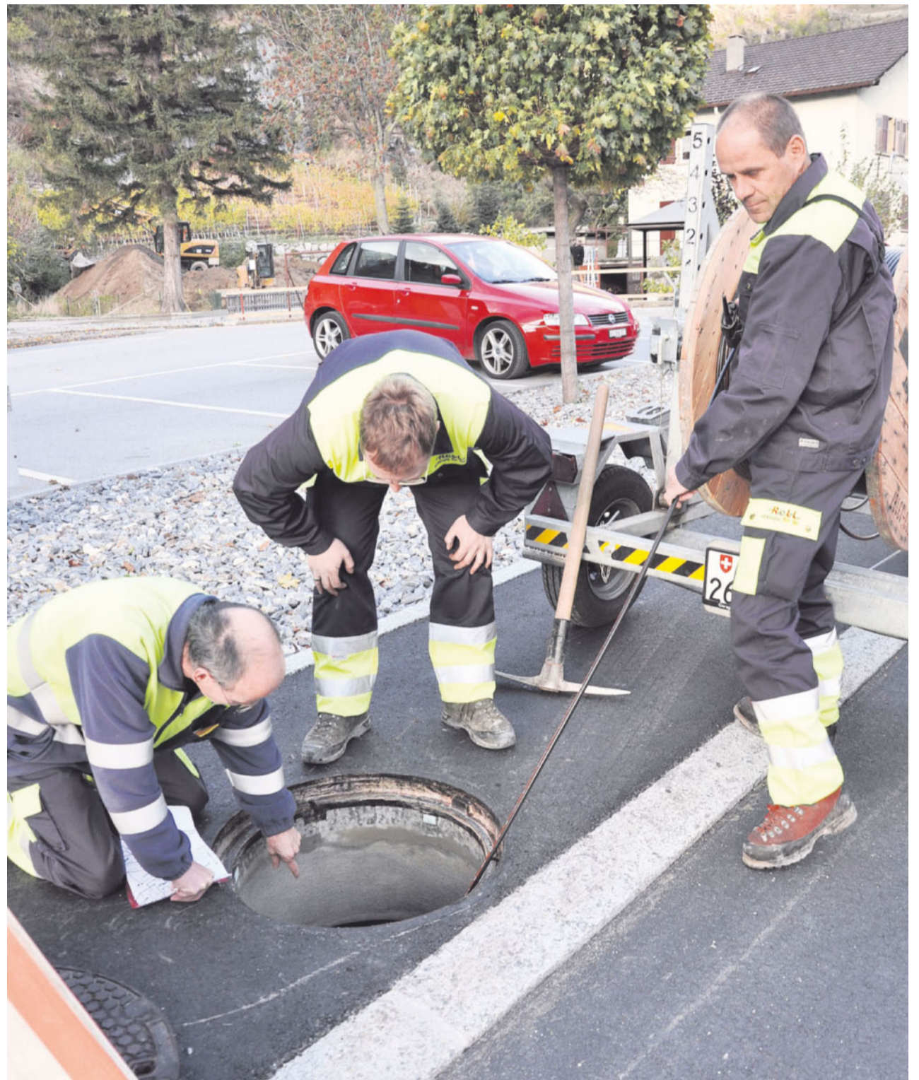
Am Werk. Die ReLL-Mitarbeiter Guido Bregy (links), Michel Karlen und Fridolin Holzer verlegen in Gampel bereits die ersten Glasfaserkabel. Von dort aus breitet sich das Netz sternförmig in die Gemeinde aus.
